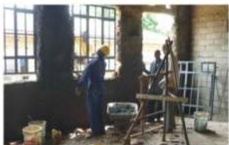
Bauarbeiten am neuen Gebäude der Kendu Bay Health Clinic
