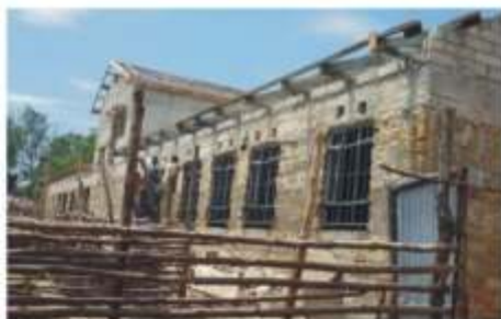
Erweiterungsbau der Kendu Bay Health Clinic
